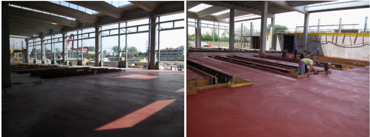
Pavimentazione interna – maggio 2009
