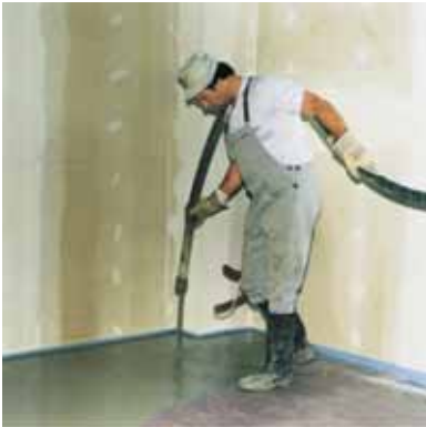
Sulle superfici estese PCI Periplan plus viene applicato in modo razionale mediante pompaggio.
