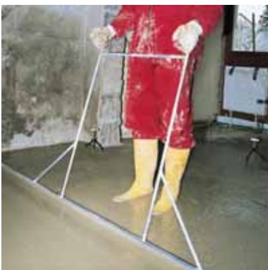
.....stendere la malta e lavorarla con la staggia di livellamento.
