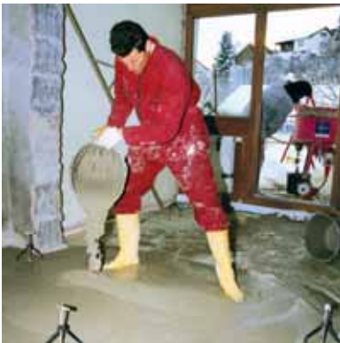
Versare PCI Periplan plus sullo strato di separazione o sul primer asciutto e indurito....
