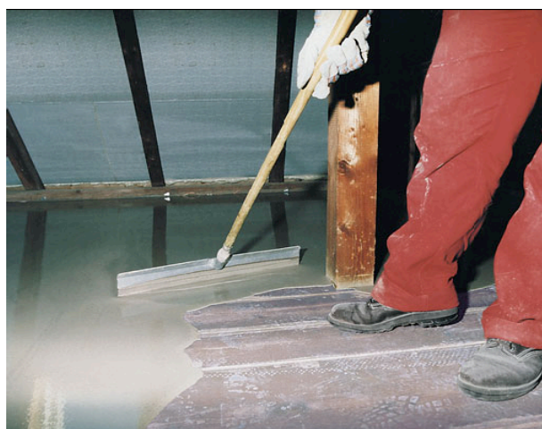
PCI Periplan extra fibrorinforzato è ideale per lavori di rinnovamento e ammodernamento nella livellatura di pavimenti in tavolati di legno e in truciolare.
