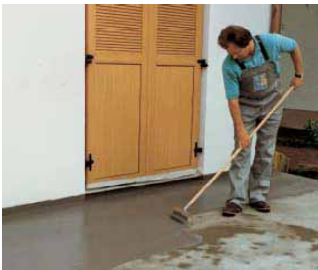
Applicare a pennello il primo strato di PCI Perilastic Flex 2K in modo uniforme e continuo.
