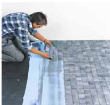
Le piastrelle e le lastre vengono adagiate e allineate sul letto di adesivo.
