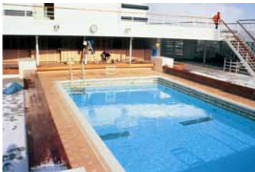
Piastrelle posate con PCI Collastic sul ponte di una nave.
