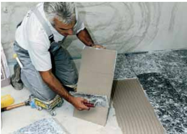
Per l'incollaggio senza vuoti si applica uno strato di malta anche sul dorso delle piastrelle.
